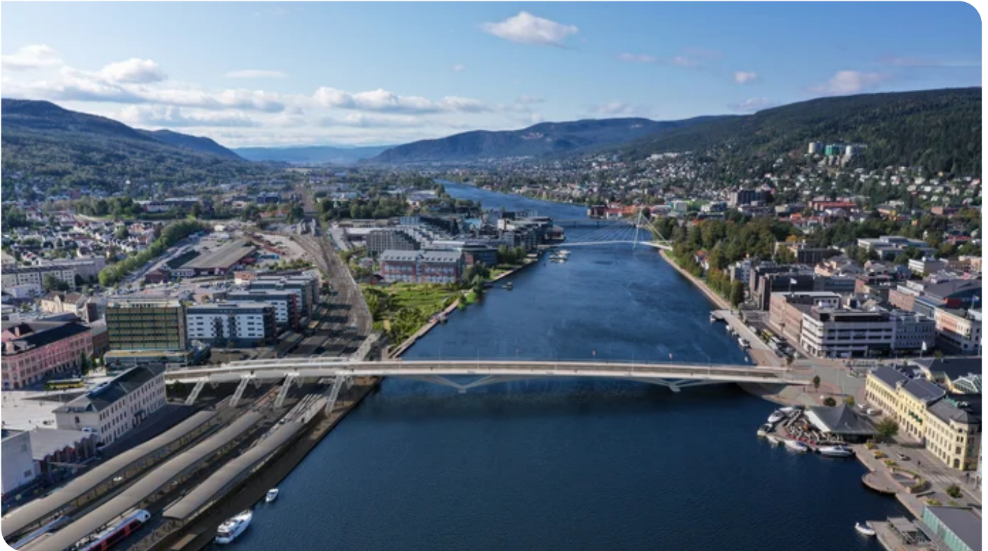
Beim Bau der Bybrua im norwegischen Drammen dürfen die durchziehenden Lachse nicht gestört werden. (c) PORR
