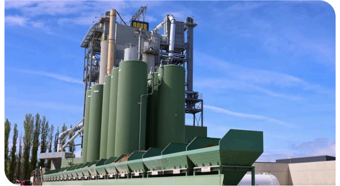
Die Asphaltmischanlage der PORR in Wien-Simmering. (c) PORR
