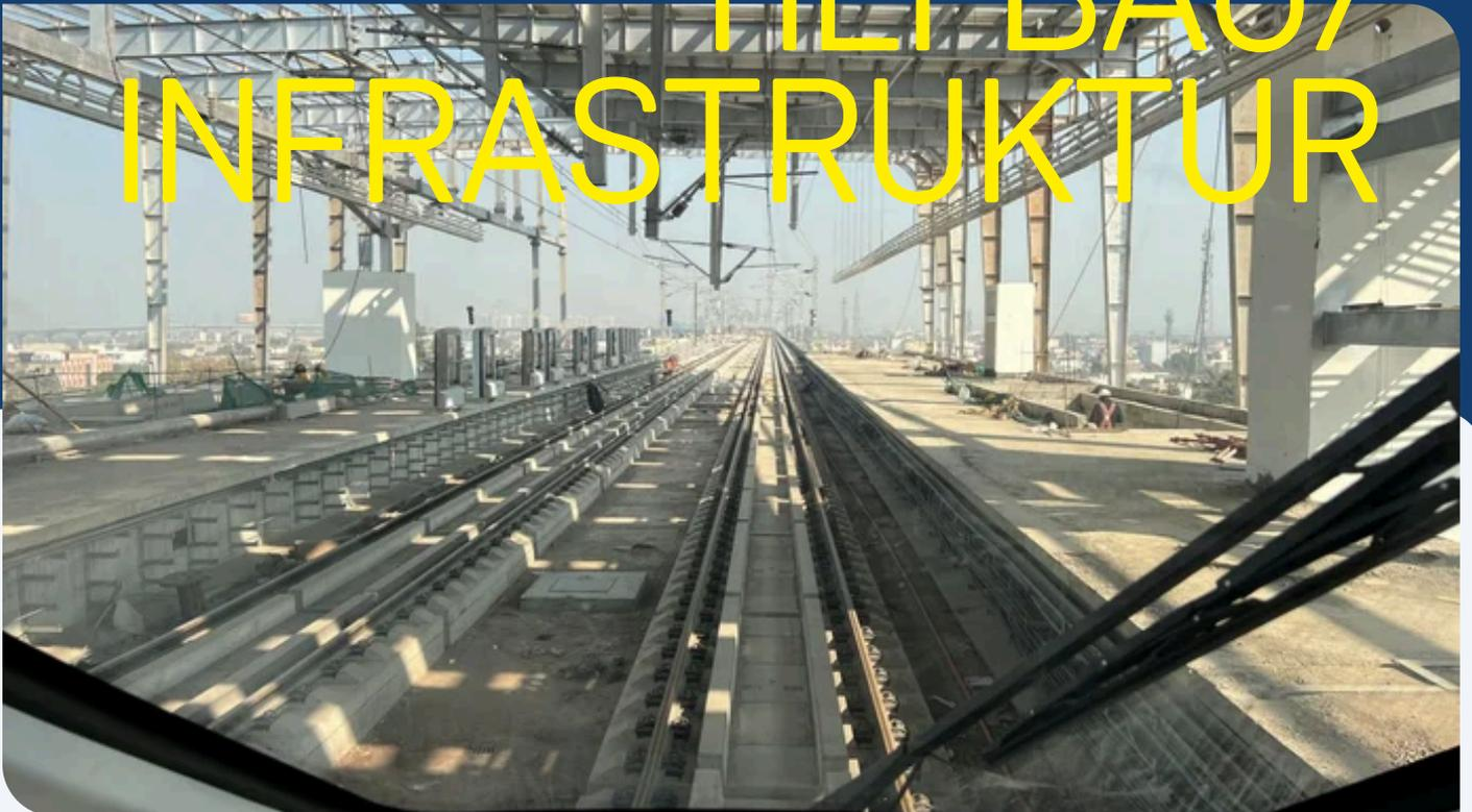
Zwischen Delhi und Meerut ist man nun besonders schnell unterwegs: Denn die PORR hat 165 km des gemeinsam mit den ÖBB entwickelte Slab Track Austria System verlegt. Damit ist der neue, zweigleisige und 82 km lange Korridor mit einer kommerziellen Geschwindigkeit von 160 km/h die derzeit schnellste in Betrieb befindliche Bahnstrecke in Indien. Das reduziert die Reisezeit auf rund eine Stunde.
