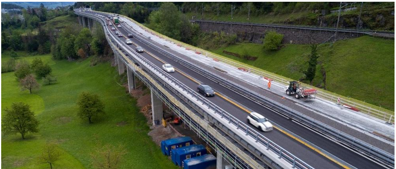
Die Brücke Linden mit seitlichem Untersichtgerüst und neuem Konsolkopf. Quelle: PORR AG
