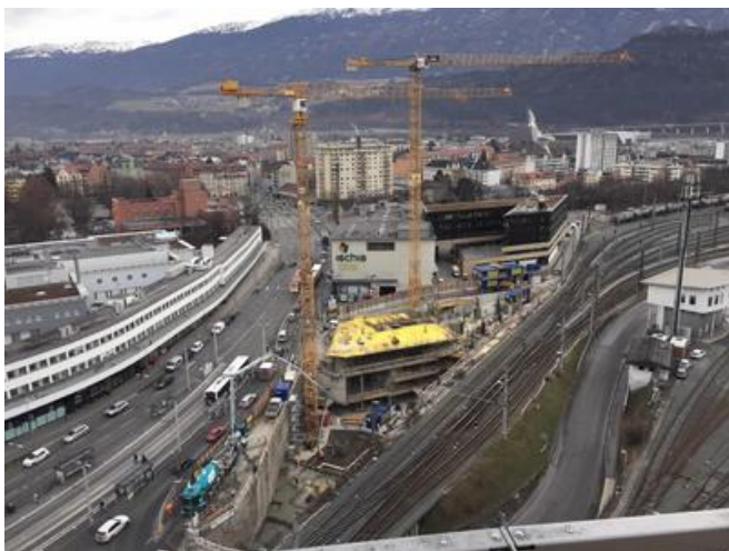
Die dem Baufeld am nächsten liegenden Bahngleise wurden für zwei Monate außer Betrieb genommen. In dieser Zeit stellte die PORR das Erdgeschoss bis zum dritten Obergeschoss her. Quelle: PORR Bau GmbH
