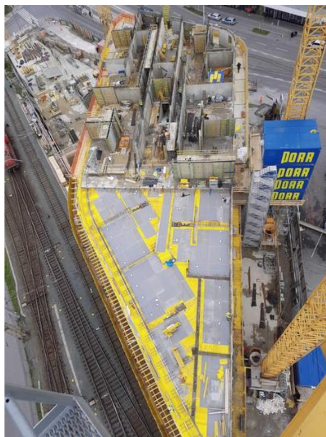
Der Rohbau des sechsten Obergeschosses aus der Vogelperspektive. Quelle: PORR Bau GmbH
