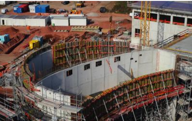
Zur größten baulichen Herausforderung wurde der Bühnenturm mit einer gebogenen Stahlbetonwand. Quelle: BBGS GmbH
