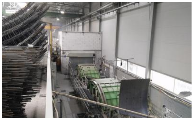
Die Tübbingauskleidung wird vor Ort in einer Feldfabrik mittels Umlaufanlage produziert und gelagert. Quelle: ARGE GKI Maria Stein
