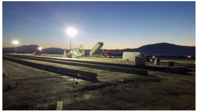
Feste Stahlträger wurden zur Schalung der Betonschicht eingesetzt. Quelle: PORR Construct
