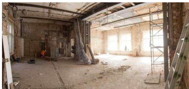
...und während der Umbauarbeiten Quelle: PORR
