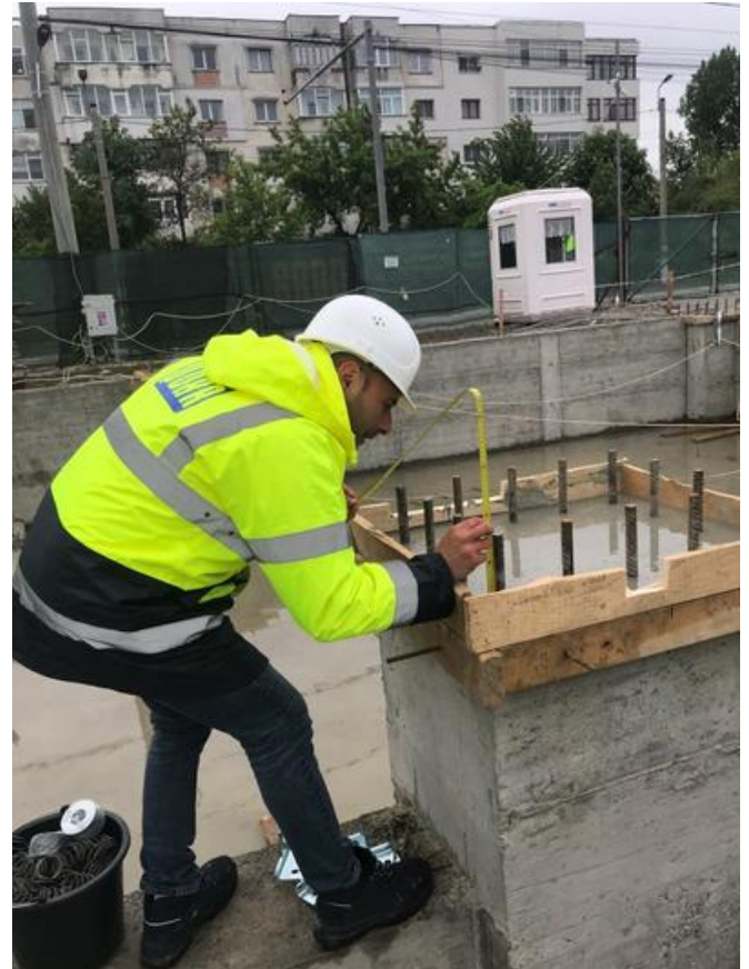
Exakte Platzierung der Bewehrungsstäbe für die Montage der Spleißmuffen. Quelle: PORR Construct
