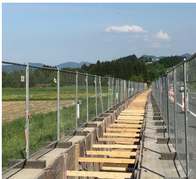
Fernwärmeleitung in Pöckau. Quelle: PORR
