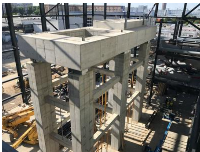
Der Turbinentisch nach erfolgreicher Fertigstellung. Quelle: PORR/Fabian Hemauer
