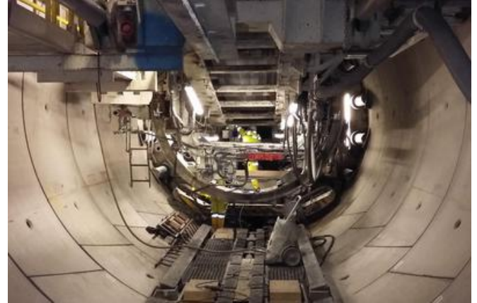
Die beiden Tunnelbohrmaschinen mussten sich fast 20 km durch grauen Bündner Schiefer graben. Quelle: ARGE GKI Maria Stein
