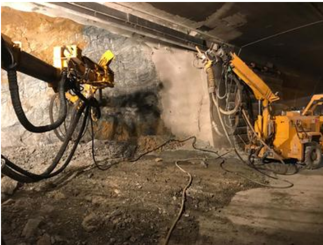
Um den Bestand nicht zu gefährden, wurden sämtliche Sprengungen mit Erschütterungsmessgeräten überwacht. Quelle: Thomas Exel
