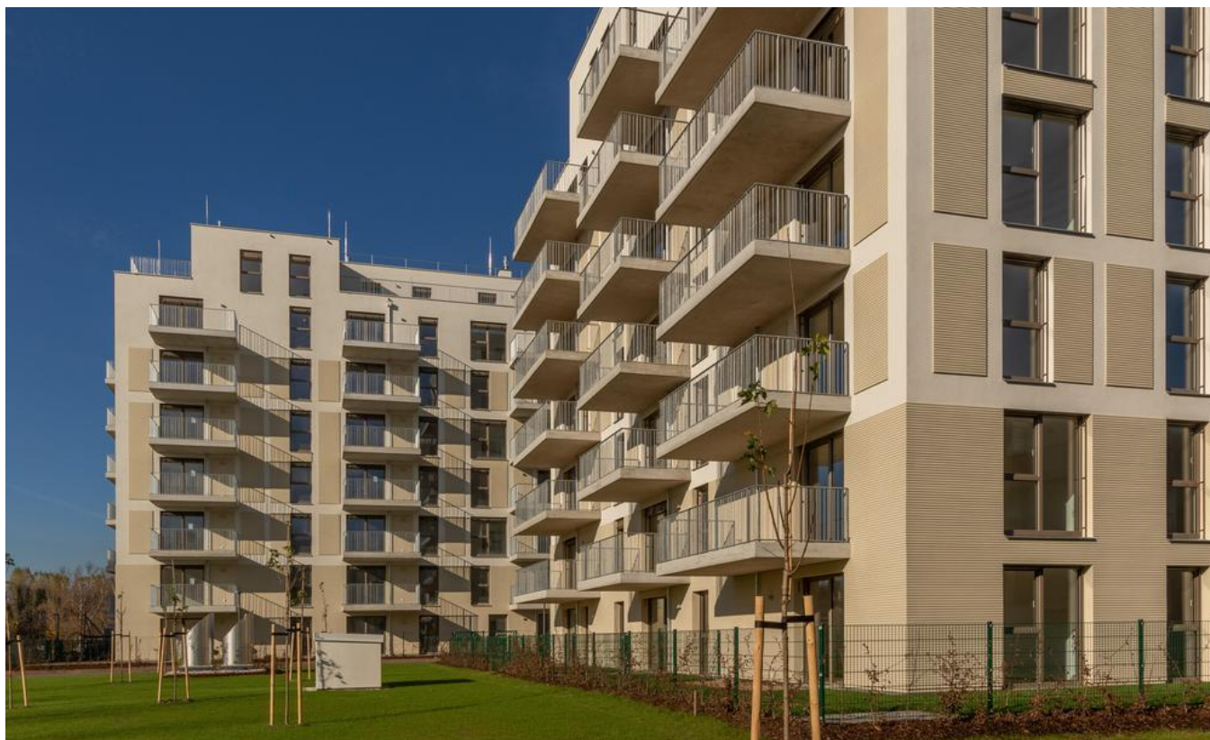
Mit ihren Fassadenprofilen im Wellendesign hebt sich die Wohnhausanlage optisch deutlich von ähnlichen Projekten ab. Quelle: Austrotherm
