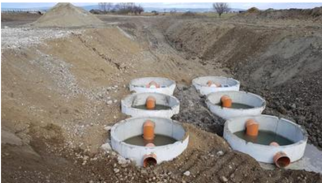
Im zweireihigen Ölabscheidersystem wird das Wasser gereinigt. Quelle: PORR Construct
