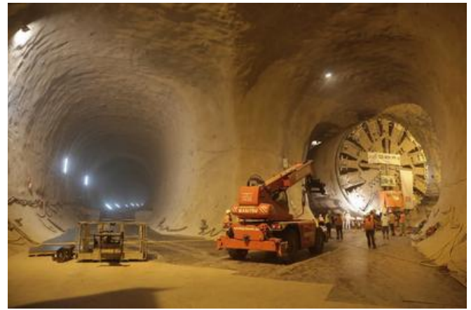
Besonders spektakulär war die Drehung des Schildteils durch die Wendekaverne. Quelle: ATCOST21
