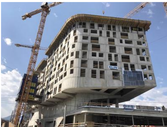
Die auskragende Architektur macht PEMA 2 zu einem echten Blickfang. Quelle: PORR Bau GmbH
