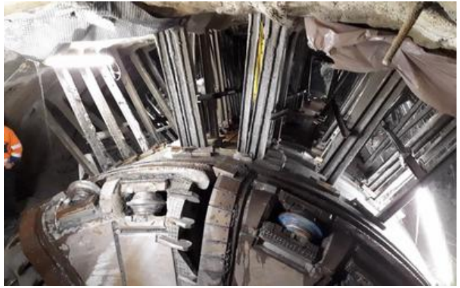
Mehrmals musste der verklemmte Schildmantel durch Überfirstung freigelegt werden. Quelle: ARGE GKI Maria Stein
