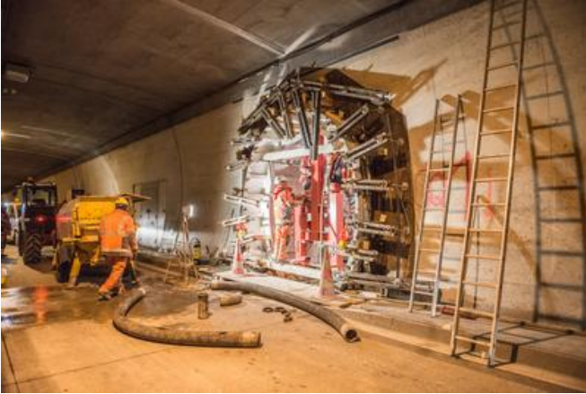
Insgesamt wurden fünf befahrbare und 15 begehbare Querschläge errichtet. Quelle: Thomas Exel
