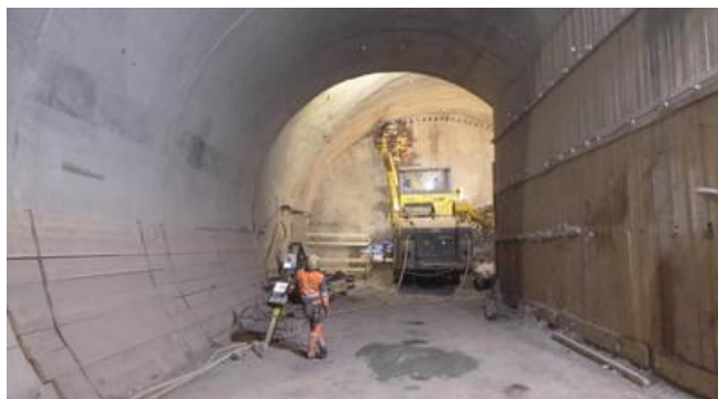
Ausbruchsquerschnitte bis zu 200 m 2 . Quelle: ATCOST21
