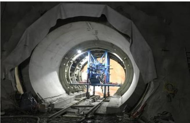
Die Betonage des Sohlgewölbes und des Gewölbes erfolgt nach dem Einbau der Rundumabdichtung. Quelle: PORR
