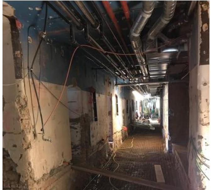
Mit Injektionen wurden die meterdicken Ziegelwänden im Untergeschoss trocken gelegt. Quelle: PORR
