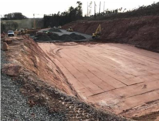
Für den Taktkeller musste ein Aushub von rund 25.000 m<sup>3</sup> gelöst und zur Wiederverfüllung seitlich gelagert werden. Quelle: PORR
