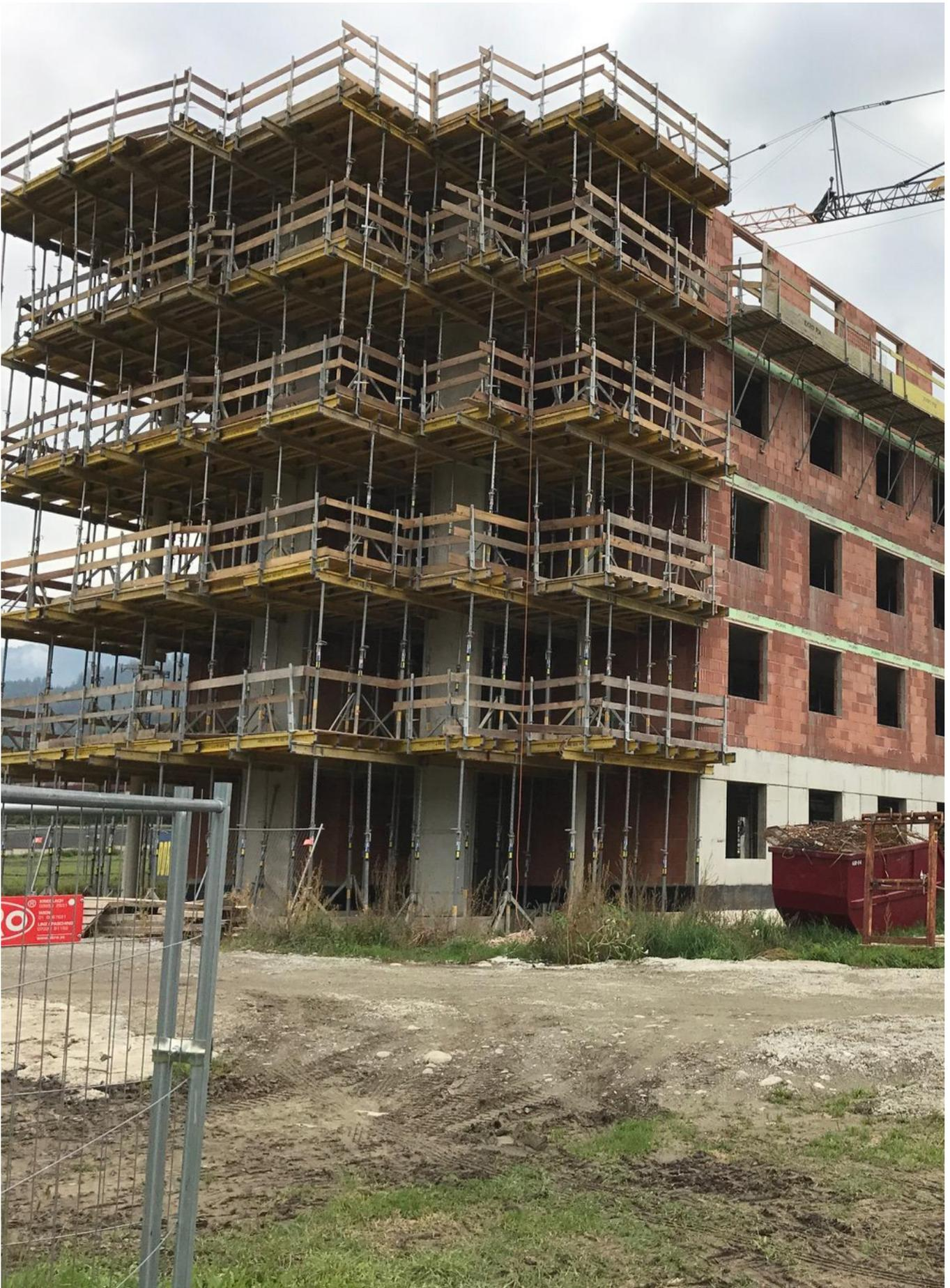
Die Außenwände sowie die tragenden Wände im Bereich der Treppenhäuser bestehen aus Objekt-Hochlochziegel. Quelle: PORR
