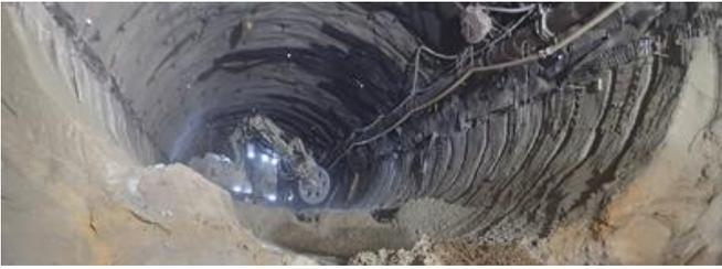
Das bestehende Kalottensohlgewölbe wurde vorausseilend mit einem Tunnelbagger mit angebautem Schneidrad vorgeschritten. Quelle: PORR
