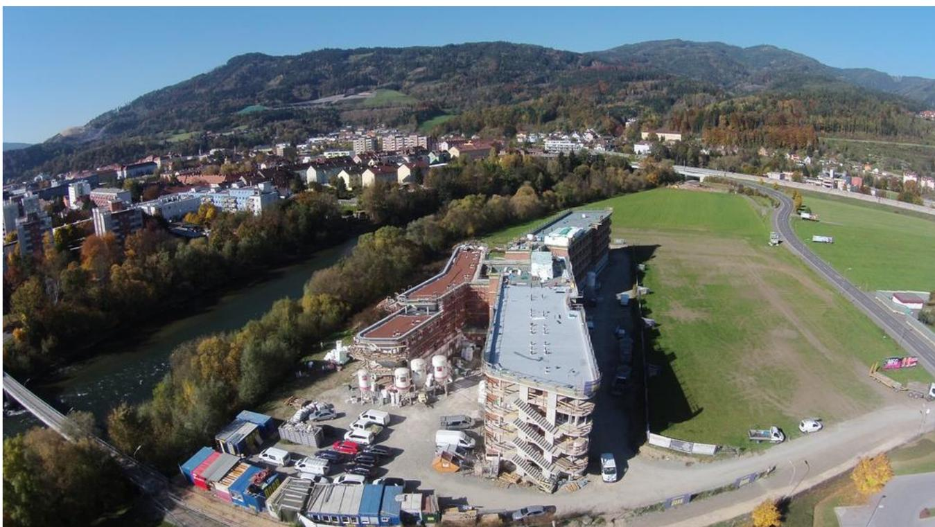
Die Dächer wurden als Flachdach ausgeführt. Der niedrigere Bauteil wurde mit einer extensiven Dachbegrünung versehen. Quelle: PORR
