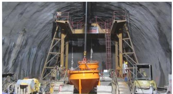
Die Arbeitsbühne für den Gleitbeton wurde in Folge als Plattform für sämtliche Schachtarbeiten verwendet. Quelle: ARGE GKI PRB
