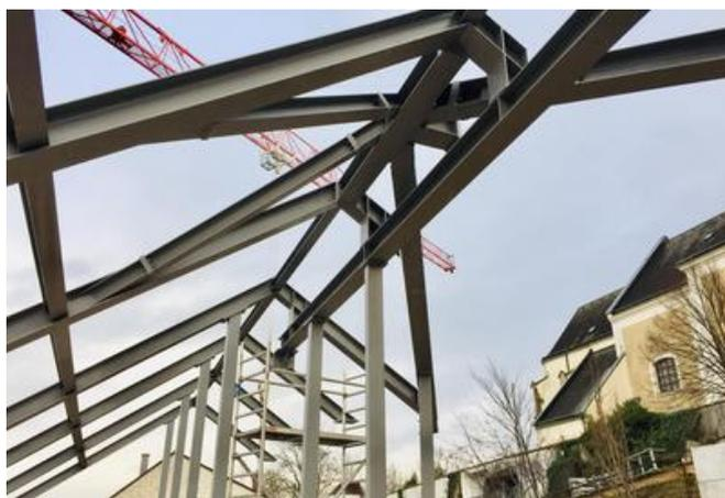
Der neue Dachstuhl erforderte eine Stahlkonstruktion, da sich über dem obersten Gesimse des alten Rathauses ein durchgängiges Lichtband befindet. Quelle: PORR
