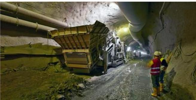
Das Ausbruchsmaterial des Sprengvortriebs wurde vor Ort von einem Becher aufbereitet und mit einer Förderbandanlage abtransportiert. Quelle: Toni Rappersberger
