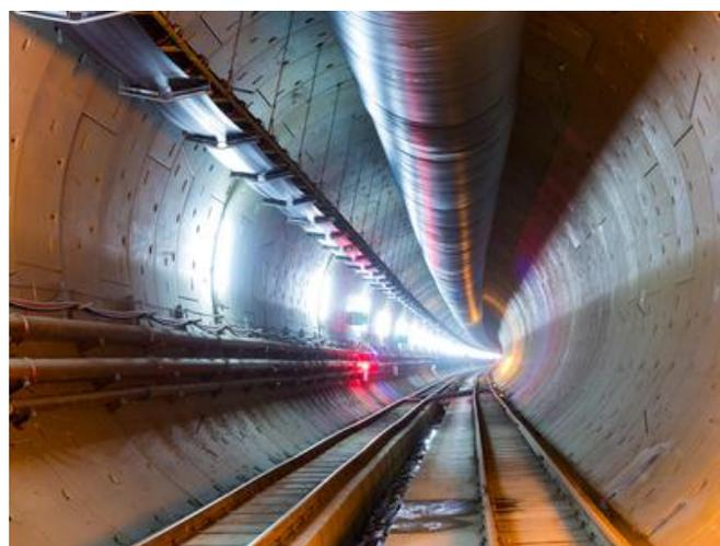
Der Vortrieb in der Nordröhre wird überwiegend mit der Tunnelvortriebsmaschine „KORA“ aufgeföhren. Quelle: Harry Schiffer
