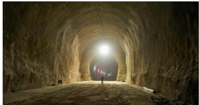
Demontagekaverne Südröhre mit einem Ausbruchsquerschnitt von 170 m<sup>2</sup> mit der Blickrichtung Klagenfurt in den bereits hergestellten Vortrieb des Fahrtunnels. Quelle: Toni Rappersberger
