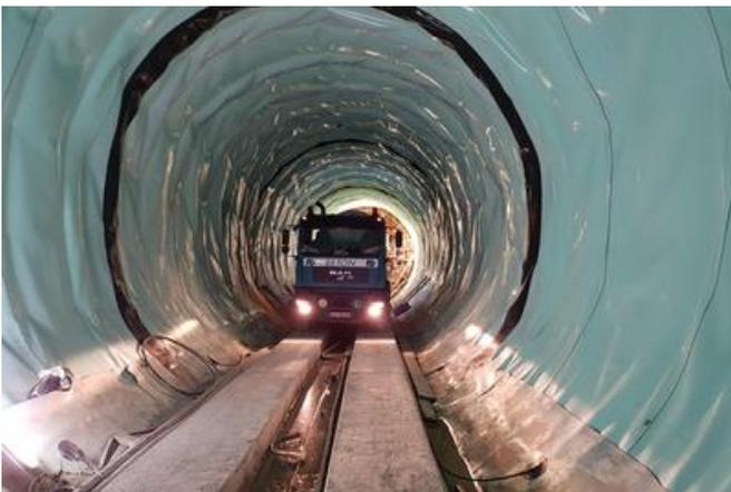
Die Abdichtung wurde parallel zum Betonbetrieb während der Nachtschichten angebracht. Quelle: ARGE GKI PRB
