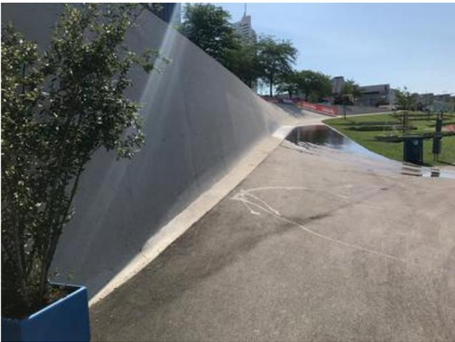
Die Sichtbetonflächen mussten mit Sonderschalungen angefertigt werden. Quelle: PORR
