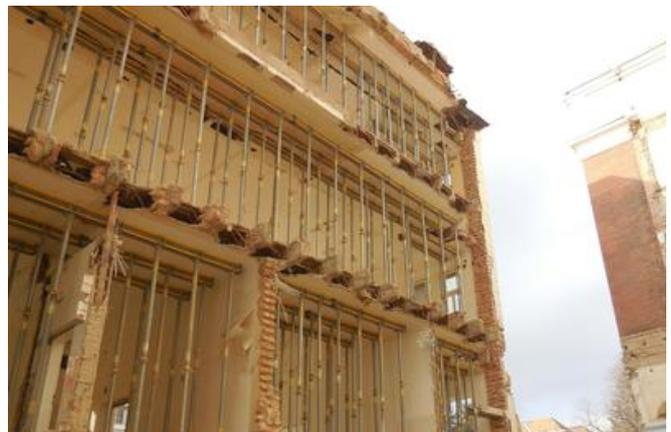
Die Decken mussten im Zuge der Abbrucharbeiten mehrfach lastmäßig umgelagert und durch Unterstellungen abgesichert werden. Quelle: PORR
