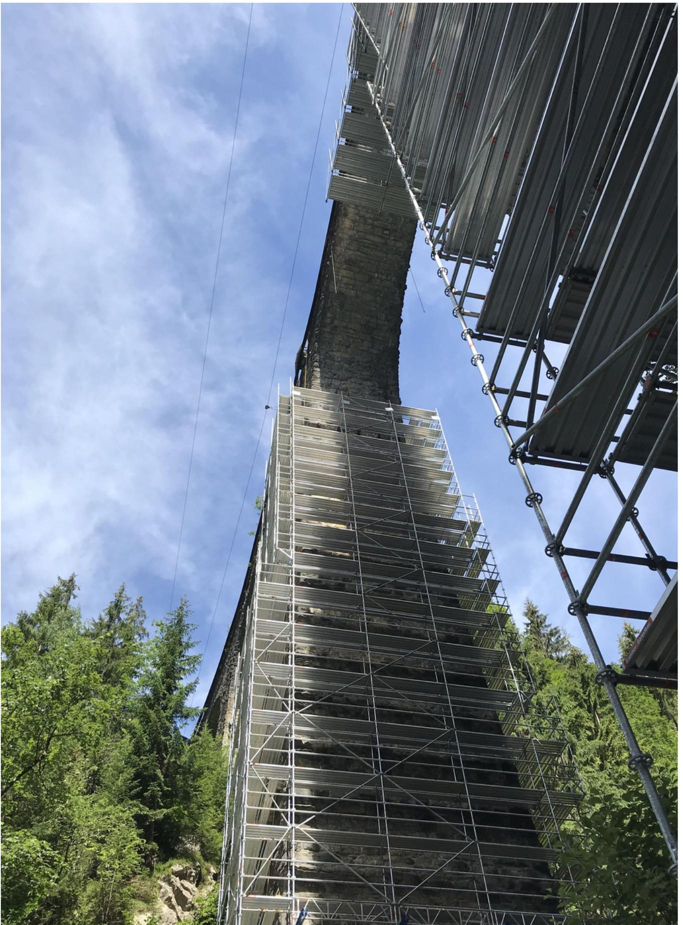
Der Gerüstbau am Pfeiler mittels Seilkran. Quelle: PORR
