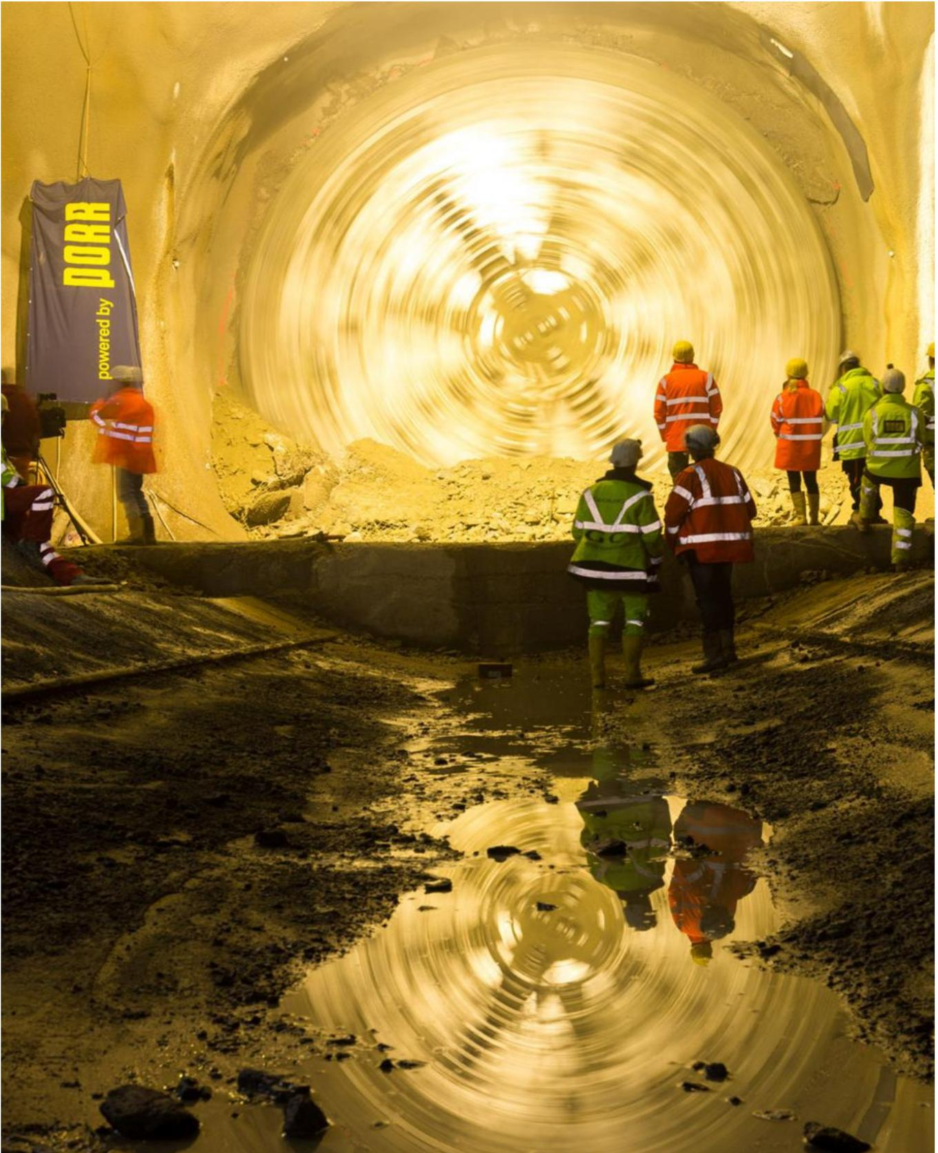
In der Nordröhre wird die Tübbingröhre als einschaliger Ausbau errichtet. Quelle: Harry Schiffer
