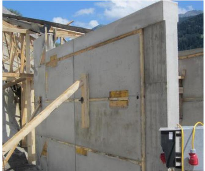
Im Betonwerk TB Stams wurde ein Großversuch durchgeführt, um die richtige Betonrezeptur für die Hinterbetonage zu finden. Quelle: ARGE GKI PRB
