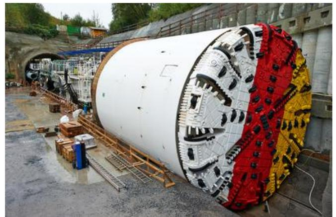
Die Montage der TVM "KORA" wurde in der Baugrube Mitterpichling durchgeführt. Der Bohrkopf ist in den Kärntner Landesfarben gehalten. Quelle: Toni Rappersberger
