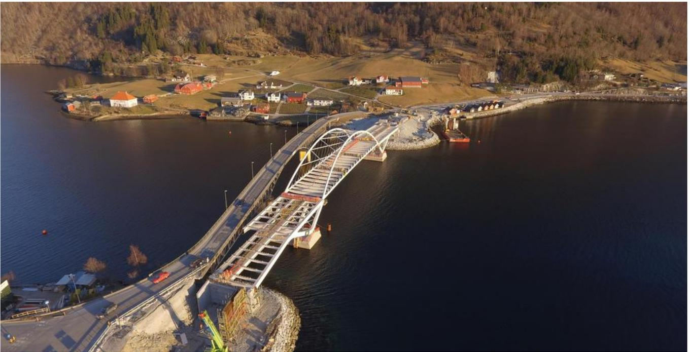
Neben dem Neubau der Brücke zählte auch die Errichtung eines Kreisverkehrs und der Abbruch der alten Brücke zum Auftrag. Quelle: PNC Norge AS
