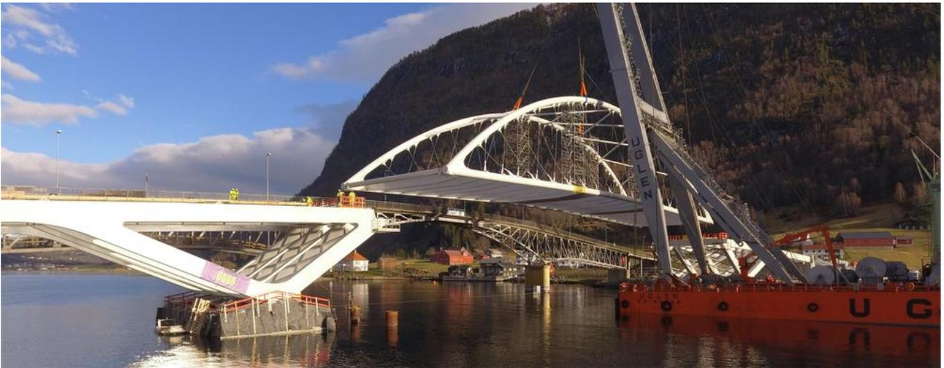
Montage der Stahlkonstruktion. Der erste Abschnitt kurz vor dem Erreichen der endgültigen Position. Quelle: PNC Norge AS
