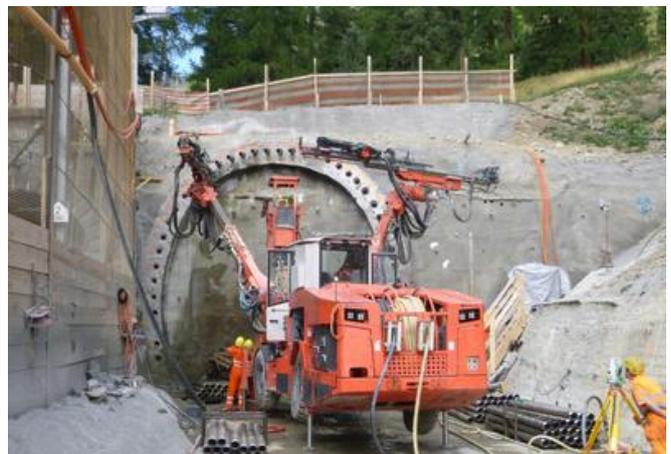
In Spinas erfolgte der Rohrschirmvortrieb bei laufendem Bahnbetrieb. Quelle: PORR
