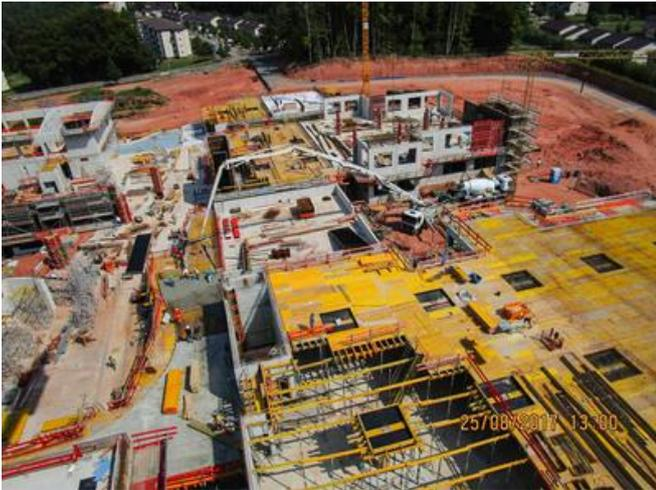
Um den erhöhten Sicherheitsanforderungen gerecht zu werden, wurde die Schule fast durchgehend in monolithischer Bauweise errichtet. Quelle: BBGS GmbH
