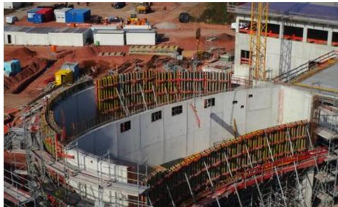
Zur größten baulichen Herausforderung wurde der Bühnenturm mit einer gebogenen Stahlbetonwand. Quelle: BBGS GmbH
