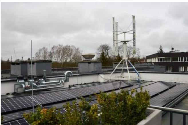
Mehrere Photovoltaik-Module und eine Windturbine am Dach liefern sauberen Strom. Quelle: PORR
