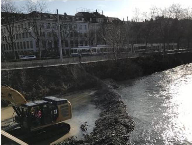
Für den reibungslosen Rückbau wurden überströmbare Dämme zur Trockenlegung der einzelnen Brückendurchlässe aufgeschüttet. Quelle: PORR
