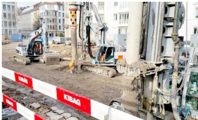
Gründungsarbeiten bis in 17 m Tiefe: Da das Bauveld im Bereich einer nicht tragfähigen Seeablagerung liegt, entschied sich die Bauherrin gegen eine umfassende Sanierung und für einen Ersatzneubau. Bild: PORR AG
