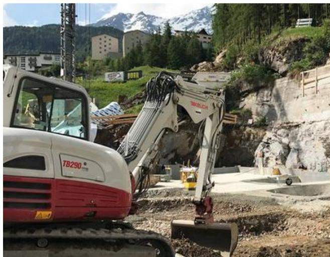
Die Baugrube wurde mit Spritzbeton gesichert. Bild: PORR AG
