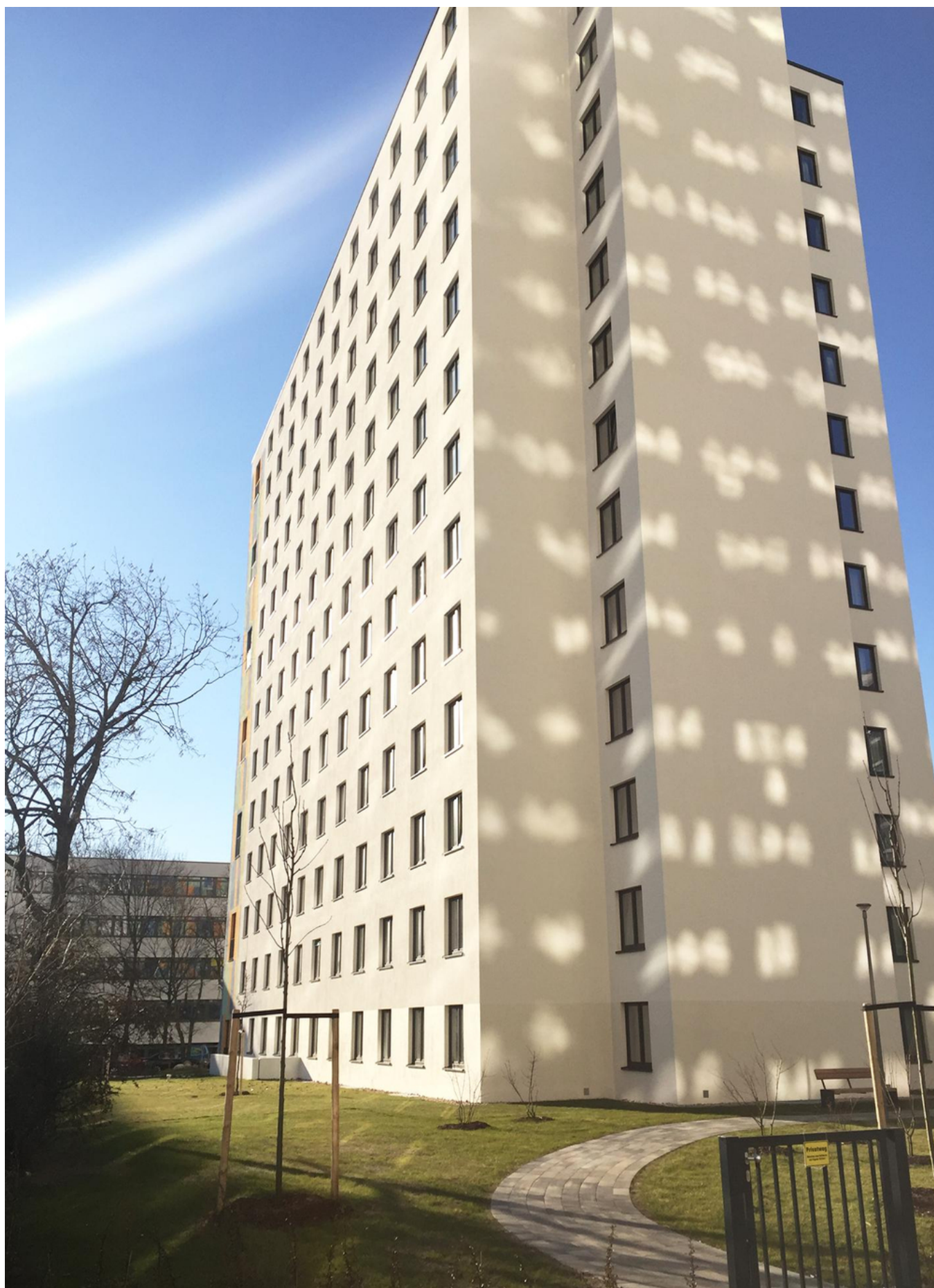
Rückansicht Studentenwohnheim. Bild: PORR
