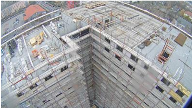
Das Tragwerk des Studentenwohnheims wurde in Schottenbauweise errichtet. Bild: PORR AG
