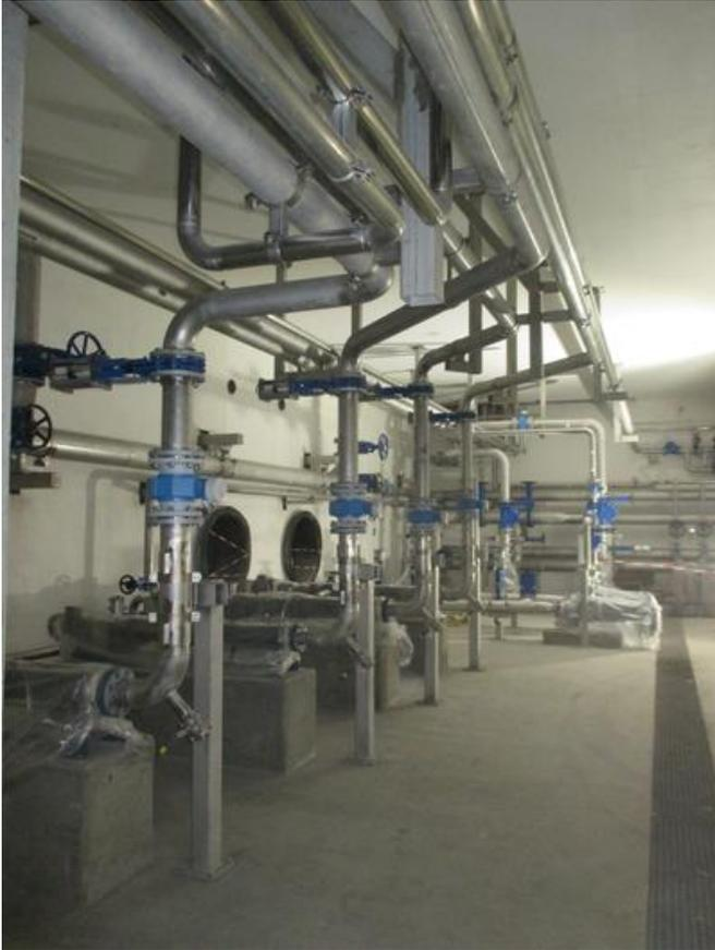
Neue Pumpen und Rohrleitungen für die erweiterte Schlammbehandlung. Quelle: PORR
