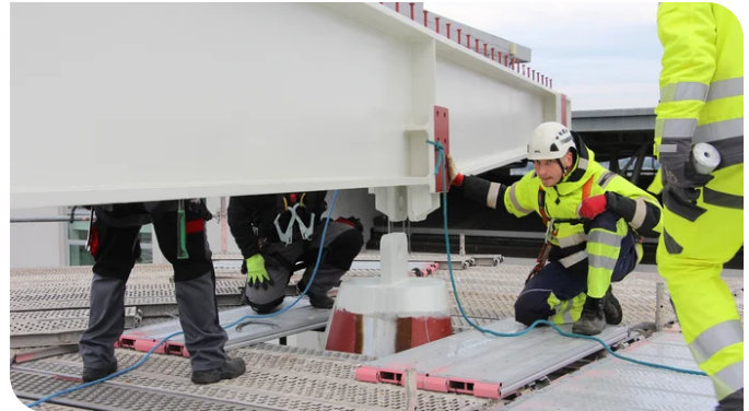
Bolzenmontage zwischen Plattform und Doppelhelix. (c) PORR
