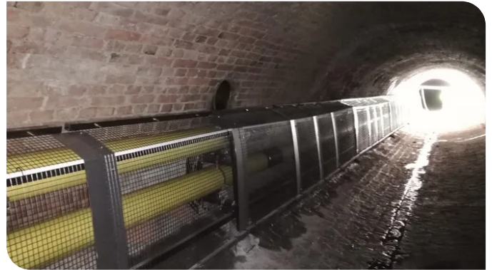
Die fertigverlegte und mittels Edelstahl-Gitterkonstruktion verkleidete Stahlleitung im Krottenbachkanal. Quelle: PORR
