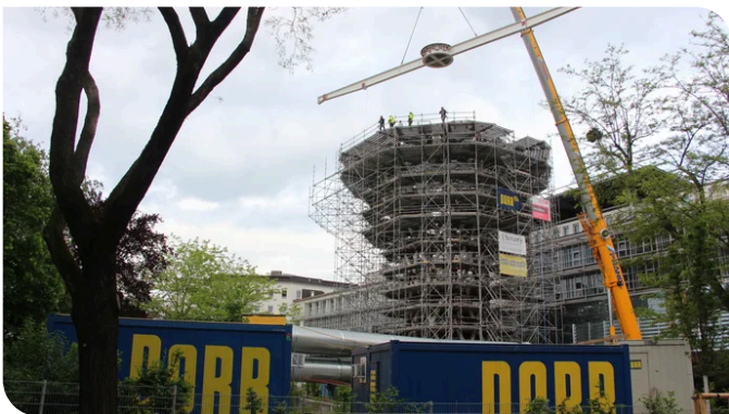
Einhub des 28m langen Plattformträgers mit zentraler Ringkonstruktion. (c) PORR
