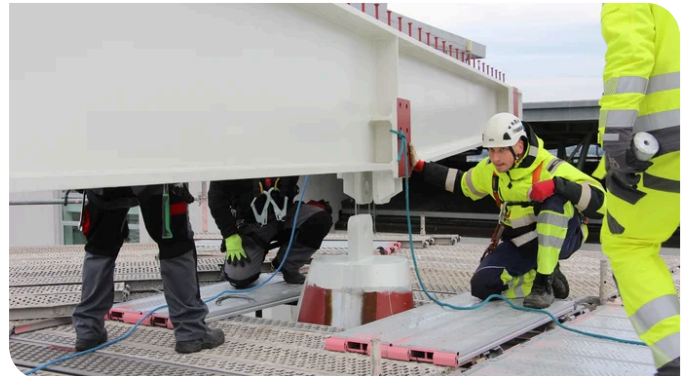
Bolzenmontage zwischen Plattform und Doppelhelix. (c) PORR
