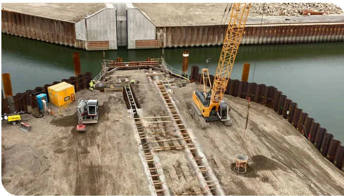
Vorbereitung der Schlitzwandarbeiten in Bauphase 2. (c) PORR
