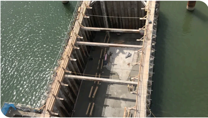
Der Spundwandkasten im Hochwasserfall. (c) PORR
