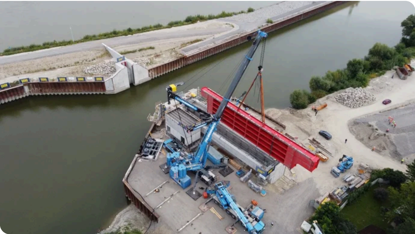
Einheben des oberen Teils des Hafentors mit rd. 130 Tonnen Gewicht. (c) Kevin Ofner, Andritz Hydro GmbH
