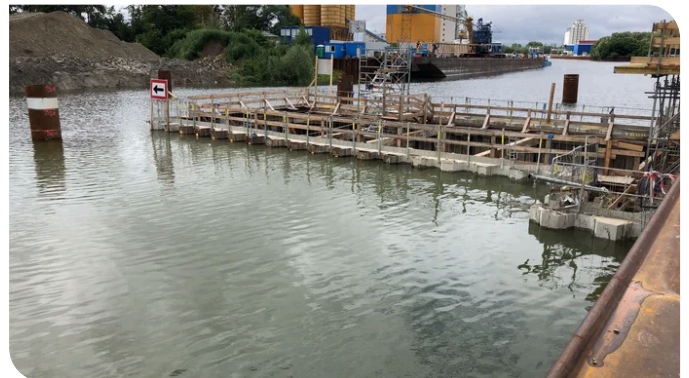
Der Spundwandkasten im Hochwasserfall. (c) PORR
