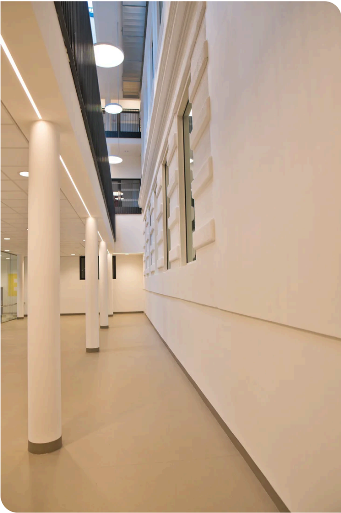
Die historische Außenfassade des Turnsaalgebäudes ist im Atrium des Neubaus sichtbar. Quelle: PORR/Philip Trummert
