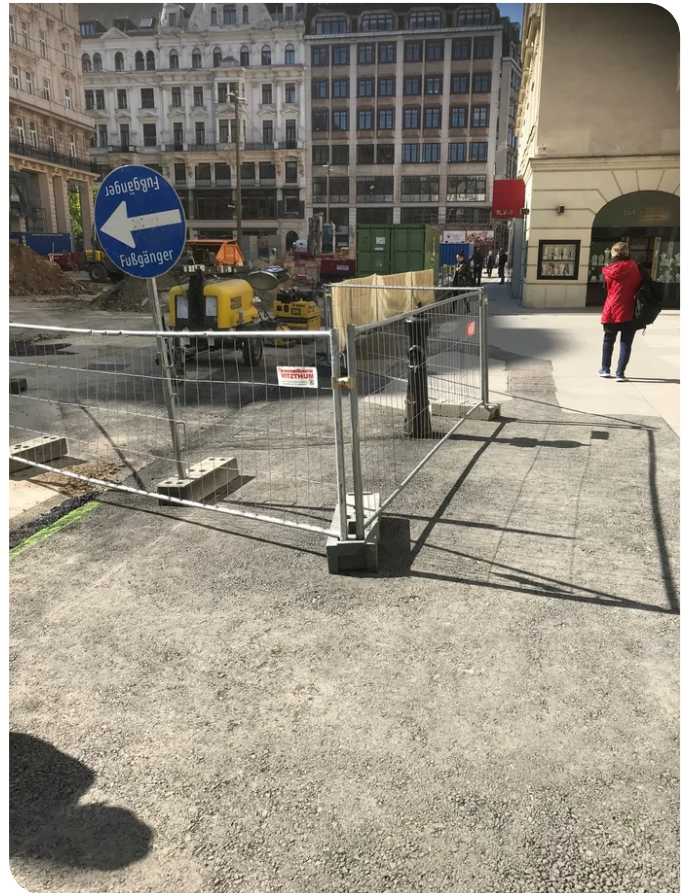
Über 1.000 m Bauzaun im Baustellenbereich. Quelle: PORR
