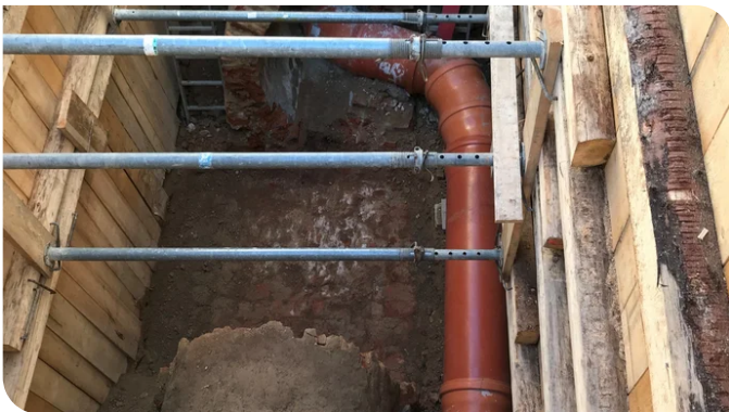
Im Zuge der Arbeiten wurden über 4.300 m 3 Holzpörlung verbaut und für die Fernwärme acht neue Schächte in Weißer-Wanne-Qualität errichtet. Quelle: PORR
