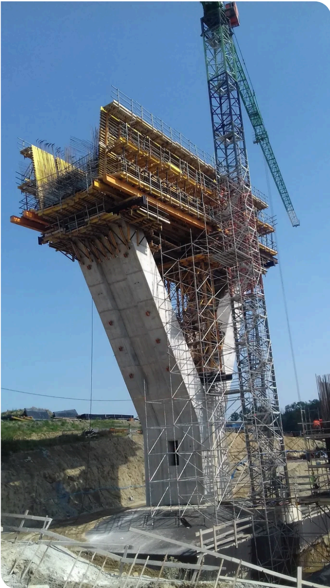
Die Y-förmigen Pfeiler der längsten Brückenfelder wurden für die Errichtung in die drei Bereiche „Pfeilerschacht“, „Kopf“ und „Arme“ unterteilt. Quelle: PORR
