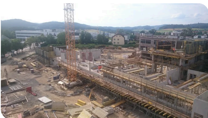
Der teils felsige, teils lehmige Untergrund erforderte individuelle Lösungen. Quelle: PORR
