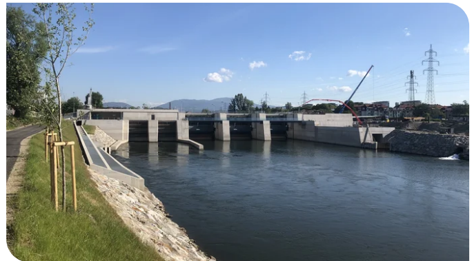
Während am Zentralen Speicherkanal noch gearbeitet wird (rechts im Bild) ist das Wehrbauwerk inklusive Fischaufstiegshilfe (links im Bild) bereits fertiggestellt. Quelle: PORR
