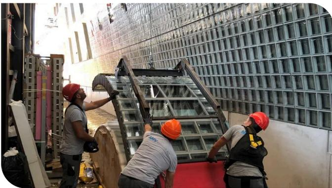
Das Einheben der Elemente wurde aufgrund der beengten Platzverhältnisse zu einer echten Herausforderung. Quelle: PORR
