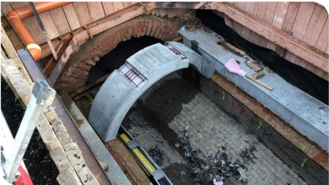
Versetzen der Betonfertigteile zum Verschließen des Ziegelgewölbes des Krottenbachkanals. Quelle: PORR
