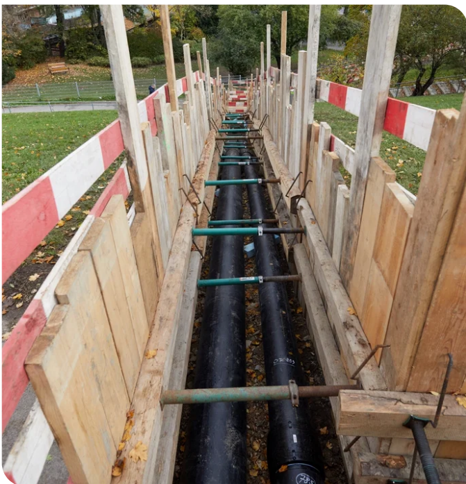
Die neu verlegte Fernkälteleitung mit Blick in den Wertheimsteinpark. Quelle: PORR
