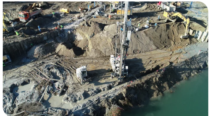
Die von der PORR geplante alternative Ausführung der Baugrube wurde in einem Großversuch in Himberg vorab auf ihre Tauglichkeit getestet. Quelle: Markus Trinkl
