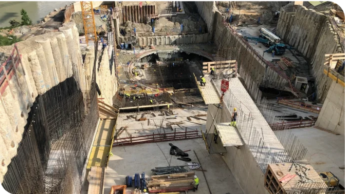
Die Bodenplatte ist beinahe fertiggestellt. Quelle: Thomas Wieczorek
