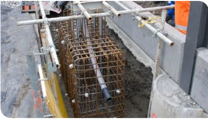
Die Fundamentarbeiten für die Masten auf offener Strecke wurden zu einer echten Herausforderung, weil die Plangrundlagen nicht den örtlichen Gegebenheiten entsprachen. Quelle: CPC/Chladek
