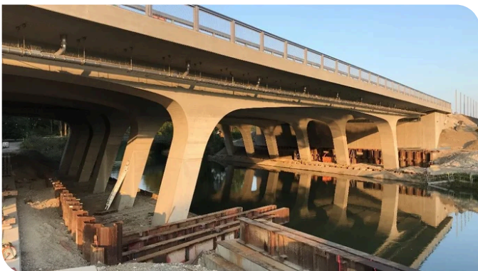
Der Auftrag umfasste auch die Straßen-, Radweg- und Landschaftsgestaltung unter den neuen Brückentragwerken. Quelle: PORR
