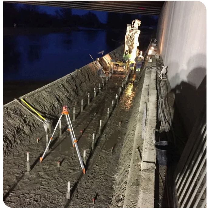
Die Kleinbohrpfähle für die Verschiebebahnen wurden von der Porr Grundbau hergestellt. Quelle: PORR
