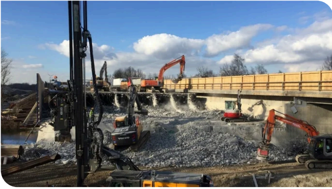
Im Hintergrund wird das bestehende Tragwerk abgebrochen, im Vordergrund werden die Spundungsarbeiten für den Neubau durchgeführt. Quelle: PORR
