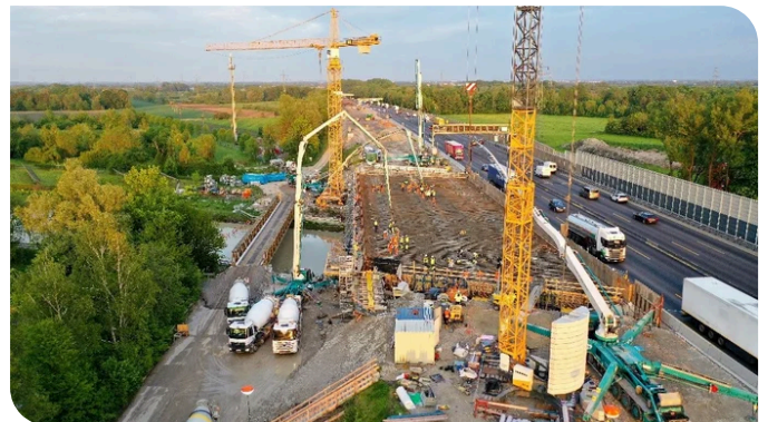
Die Anlieferung des Betons für die Betonage des Überbaus gestaltete sich aufgrund des hohen Verkehrsaufkommens als echte Herausforderung. Quelle: PORR
