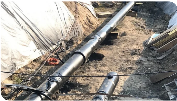
Um die beschädigte Pipeline tauschen zu können, musste sie erst auf einer Länge von 140m freigelegt werden. Quelle: PORR
