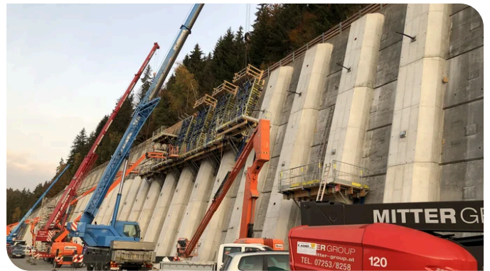
Nach den Ankerbohrungen wurden an der Ankerwand die vertikalen Lisenen betoniert. Quelle: PORR Spezialtiefbau
