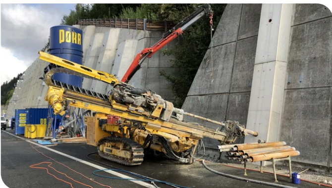
Bohrungen der unteren Ebenen wurden mit Raupenbohrgeräten durchgeführt. Quelle: PORR Spezialtiefbau
