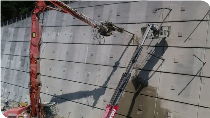
Für die Bohrungen in bis zu 20 m Höhe kam ein 60 t Bagger mit Anbaulafette zum Einsatz. Quelle: PORR Spezialtiefbau
