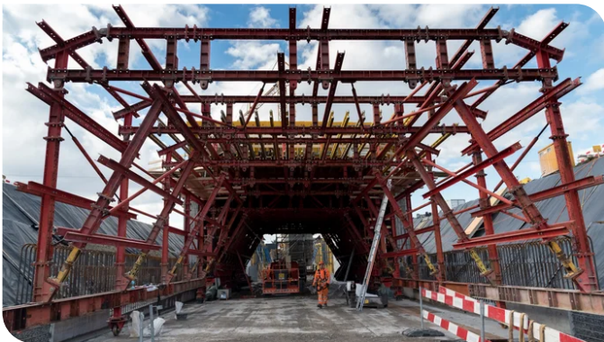
Schalwagen und Nachlaufwagen während der Montage für den Einsatz der nächsten 32 Deckenettappen. Quelle: PORR
