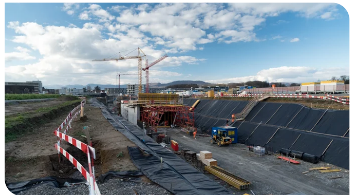
Start der 1. Betonieretappe der Tunneldecke und des Tunnelportals mit Schalwagen und Nachbehandlungswagen. Quelle: PORR
