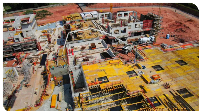
Um den erhöhten Sicherheitsanforderungen gerecht zu werden, wurde die Schule fast durchgehend in monolithischer Bauweise errichtet. Quelle: BBGS GmbH
