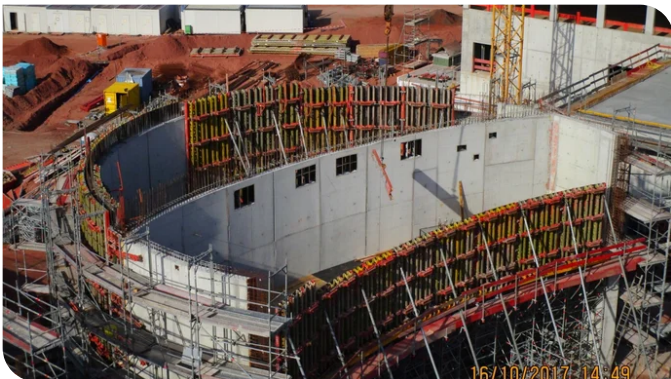
Zur größten baulichen Herausforderung wurde der Bühnenturm mit einer gebogenen Stahlbetonwand. Quelle: BBGS GmbH
