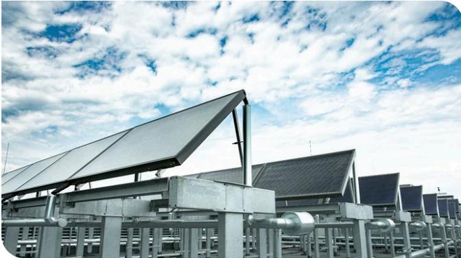
Um die Energieeffizienz des Gebäudes zu erhöhen, wurde am Dach eine Solaranlage für die Warmwasseraufbereitung errichtet. Quelle: PORR
