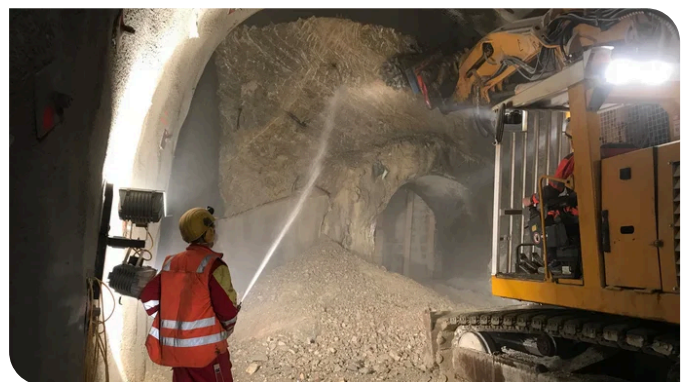
Die letzten Meter vor Erreichen der Weströhre wurde nur noch mechanisch mit einem Bagger vorgetrieben. Quelle: Thomas Exel
