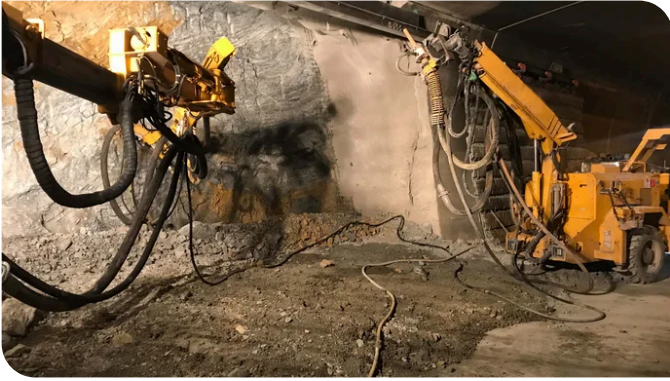
Um den Bestand nicht zu gefährden, wurden sämtliche Sprengungen mit Erschütterungsmessgeräten überwacht. Quelle: Thomas Exel
