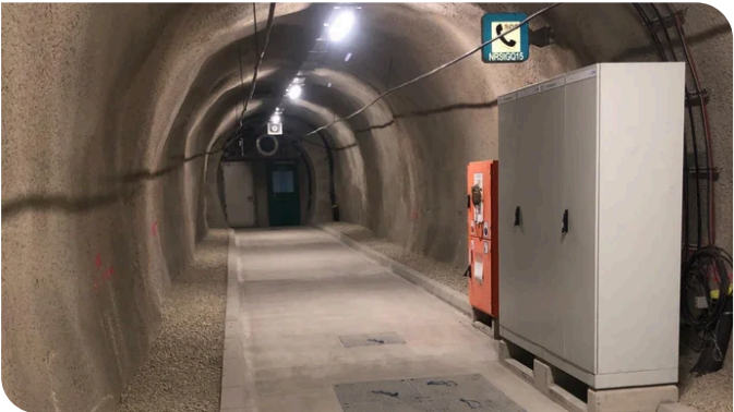
Neben den fünf befahrbaren Querschlügen wurden auch 15 begehbare Querschlüge errichtet. Quelle: Thomas Exel
