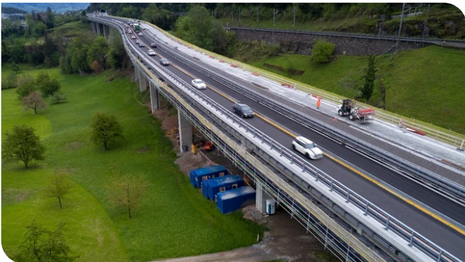
Die Brücke Linden mit seitlichem Untersichtgerüst und neuem Konsolkopf. Quelle: PORR AG
