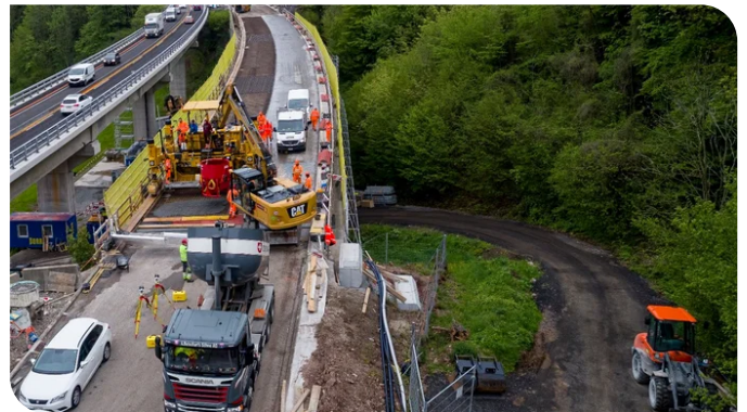
Bei hohen Tagestemperaturen musste schon um 04:00 Uhr mit dem Einbau des Ultra-Hochleistungs-Faserbeton UHFB begonnen werden. Quelle: PORR AG
