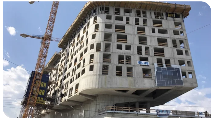
Die auskragende Architektur macht PEMA 2 zu einem echten Blickfang. Quelle: PORR Bau GmbH
