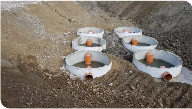
Im zweireihigen Ölabscheidersystem wird das Wasser gereingt. Quelle: PORR Construct
