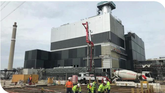
Betonage Bodenplatte Freilager für das Heizkraftwerk Marzahn. Quelle: PORR/Fabian Hemauer
