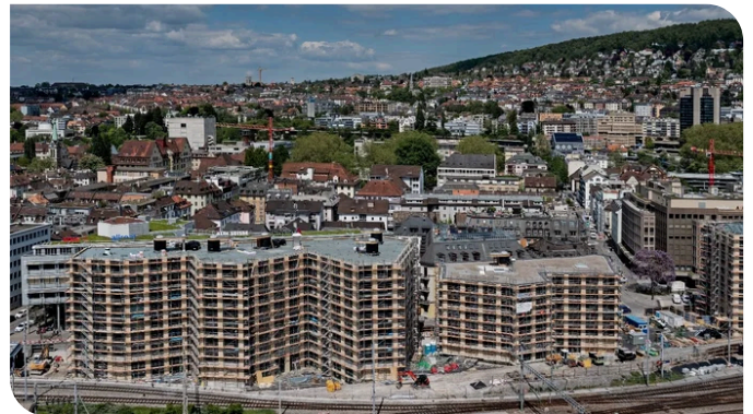
Die Gleisribüne kurz vor der Fertigstellung. Quelle: PORR
