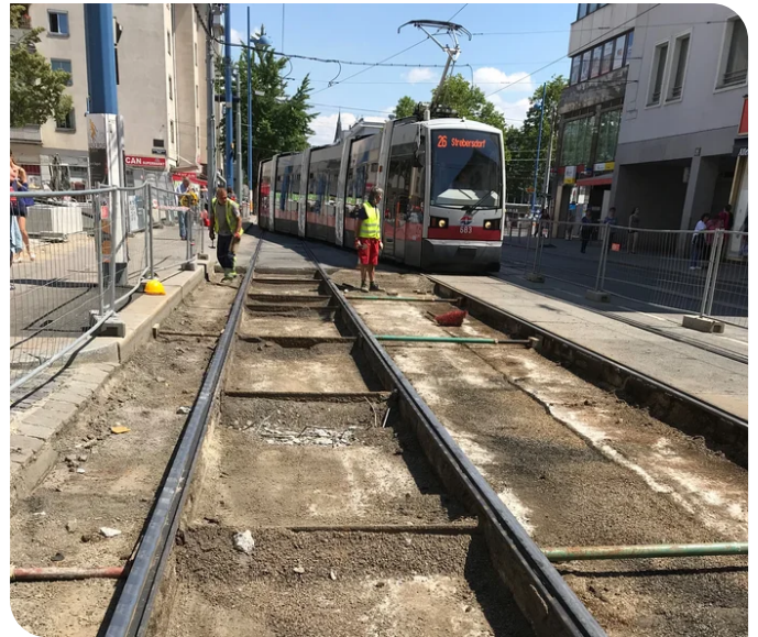
Die vorgefertigten Betondecken und das Kiesbett wurden fachgerecht demontiert. Bildquelle: PORR AG
