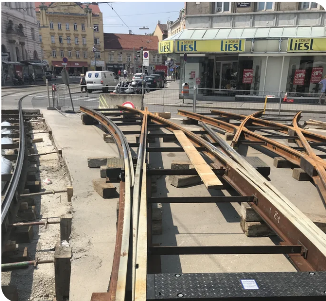
Die Rillenschienenweichen für den Kreuzungsbereich wurden vormontiert. Quelle: PORR AG
