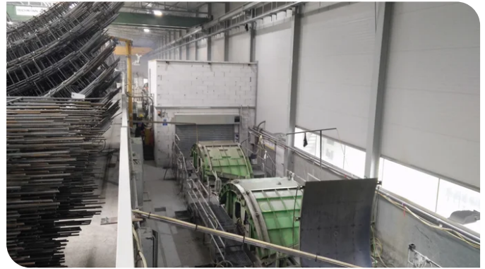
Die Tübbingauskleidung wird vor Ort in einer Feldfabrik mittels Umlaufanlage produziert und gelagert. Quelle: ARGE GKI Maria Stein
