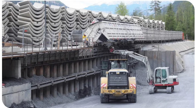
Da die Baustelleneinrichtung vom Vorunternehmer übernommen werden musste, setzte die ARGE GKI Maria Stein zur Effizienzsteigerung einige Umstrukturierungsmaßnahmen. So wurde etwa die Entleerung der Versorgungswagen auf völlig neue Beine gestellt. Quelle: ARGE GKI Maria Stein
