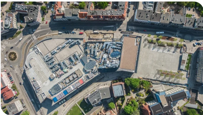
In der unmittelbaren Umgebung des Solaris-Center wurden Straßenzüge angepasst und zwei neue Kreisverkehre errichtet. Quelle: PORR
