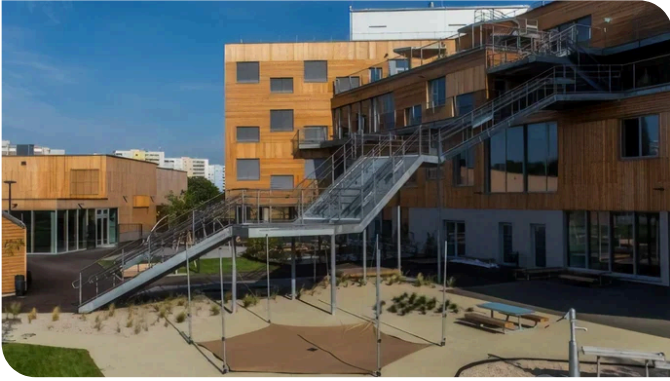
Der Schulcampus Berresgasse bildet die notwendige Bildungsinfrastruktur für ein neues Stadtentwicklungsgebiet in Wien / Hirschstetten. Quelle: Outline Pictures · Jakob Gsöllpointner
