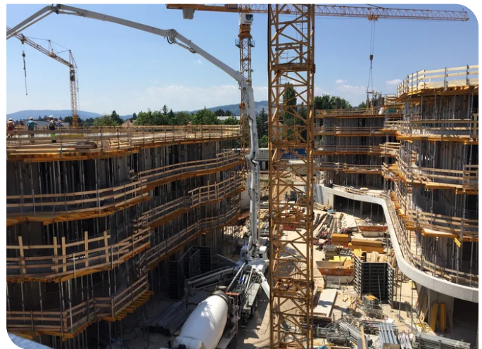
Die Schalung der insgesamt 3 km langen Balkonrandbalken stellte eine besondere Herausforderung dar. Quelle: PORR
