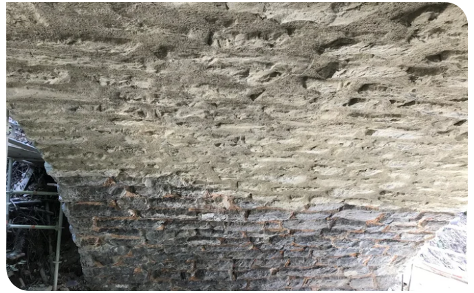
Das gesamte Mauerwerk wurde mit Hochdruckwasserstrahlen gereinigt und danach mit einem Sandstrahlgerät bearbeitet. Quelle: PORR
