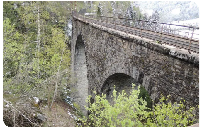
Das Schmiedobelviadukt vor Baubeginn Quelle: PORR
