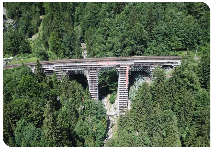
Das Schmiedobelviadukt wurde mit insgesamt 320 t Gerüstmaterial eingerüstet. Quelle: PORR
