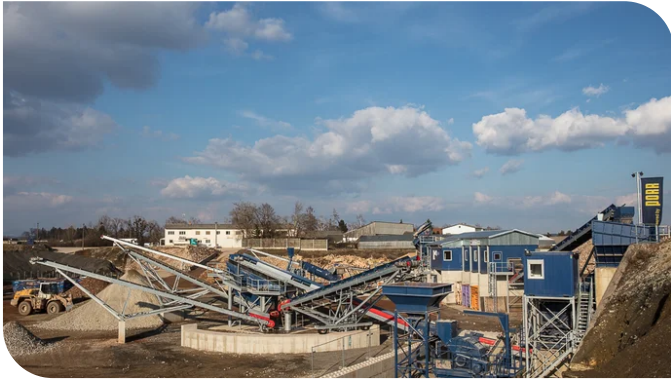
Mit der modernen Recyclinganlage ist es möglich, ein umfangreiches Sortiment an Recyclingmaterial in Produktqualität herzustellen. Quelle: Daniel Ulbricht-Sundt
