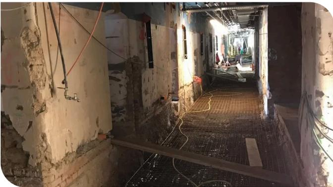
Mit Injektionen wurden die meterdicken Ziegelwänden im Untergeschoss trocken gelegt. Quelle: PORR
