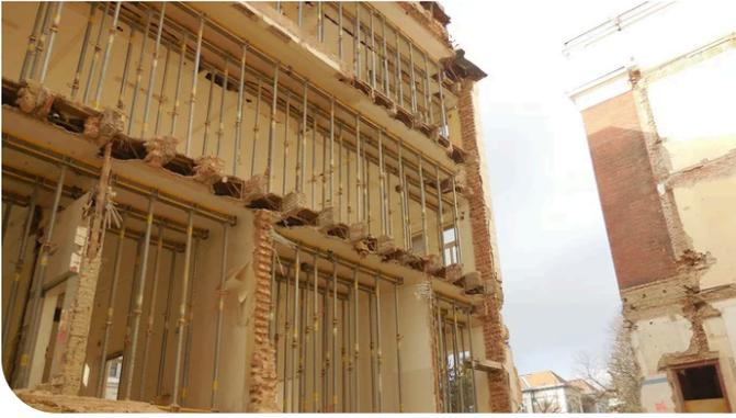
Die Decken mussten im Zuge der Abbrucharbeiten mehrfach lastmäßig umgelagert und durch Unterstellungen abgesichert werden. Quelle: PORR
