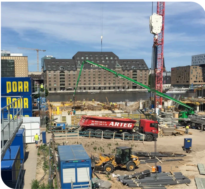
Im Verlauf der Baustelle wurden ca. 400.000 m 3 Wasser abgepumpt. Quelle: PORR
