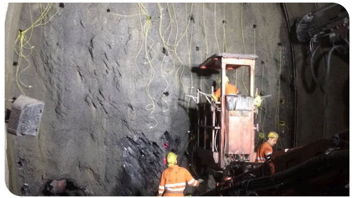
Im Allgäuschiefer konnte auf Sprengvortrieb umgestellt werden, allerdings erwies sich das Gestein als sehr nachbrüchig und schlammbildend. Quelle: PORR
