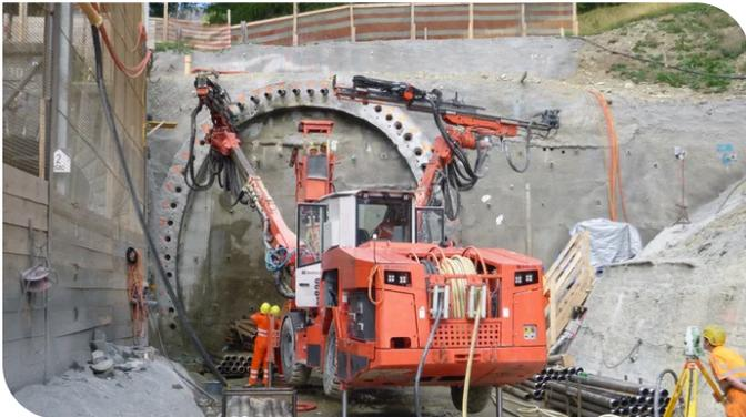
In Spinass erfolgte der Rohrschirmvortrieb bei laufendem Bahnbetrieb. Quelle: PORR
