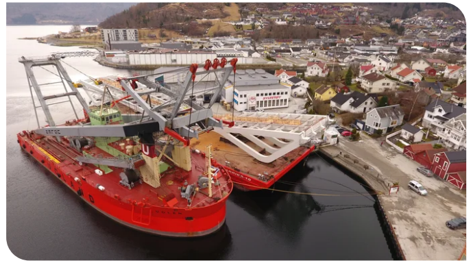
Der erste Lastkahn transportierte zwei Brückenabschnitte zum örtlichen Kai in der Nähe der Baustelle. Der 800 t schwere Schwimmkran befand sich zu diesem Zeitpunkt ebenfalls schon an Ort und Stelle. Quelle: PNC Norge AS
