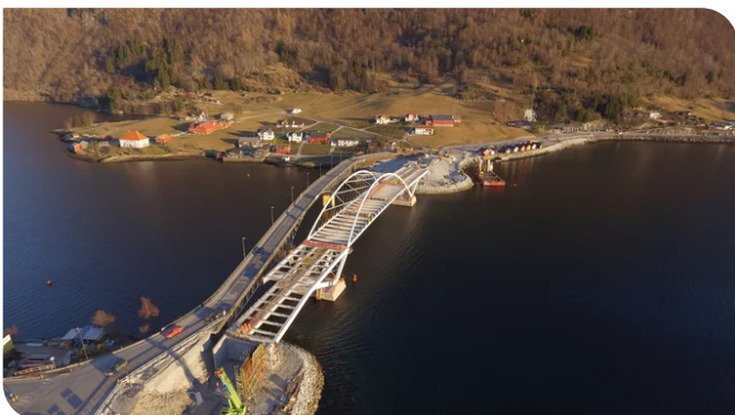
Neben dem Neubau der Brücke zählte auch die Errichtung eines Kreisverkehrs und der Abbruch der alten Brücke zum Auftrag. Quelle: PNC Norge AS Bis
