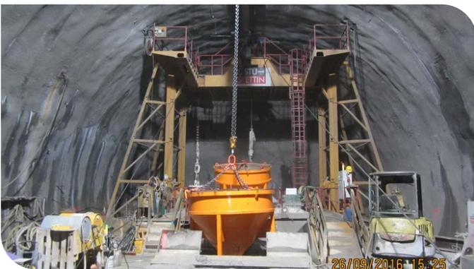
Die Arbeitsbühne für den Gleitbeton wurde in Folge als Plattform für sämtliche Schachtarbeiten verwendet. Quelle: ARGE GKI PRB
