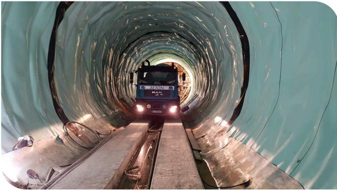
Die Abdichtung wurde parallel zum Betonbetrieb während der Nachtschichten angebracht. Quelle: ARGE GKI PRB
