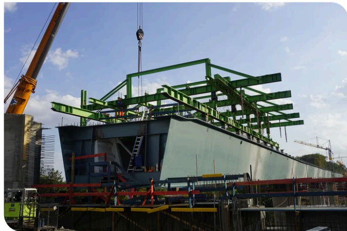
Aufbau des Schalwagens (Fa. Weise Dortmund) für die Herstellung der Verbundfahrbahnplatte. Quelle: PORR
