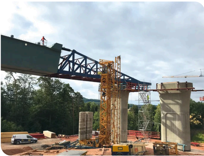
Bauteile wie Vershubwippen, ein Vorbauschabel für das Schieben der einzelnen Abschnitte (Bild) oder eine Zuganlage mit selbst konzipierten, horizontal arbeitenden Litzenhebern wurden neu entwickelt und können jetzt auch für andere Projekte verwendet werden. Quelle: PORR
