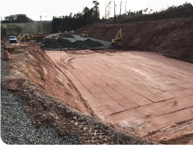
Für den Taktkeller musste ein Aushub von rund 25.000 m³ gelöst und zur Wiederverfüllung seitlich gelagert werden. Quelle: PORR
